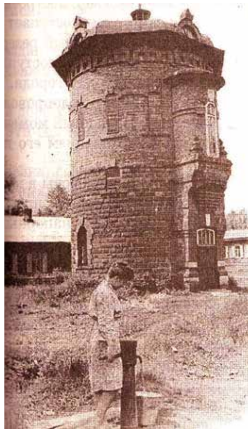
Водонапорная башня, посёлок Новочернореченский
