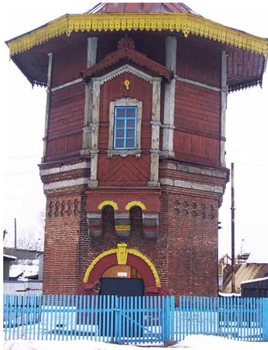
Водонапорная башня посёлка Козулька до ремонта
