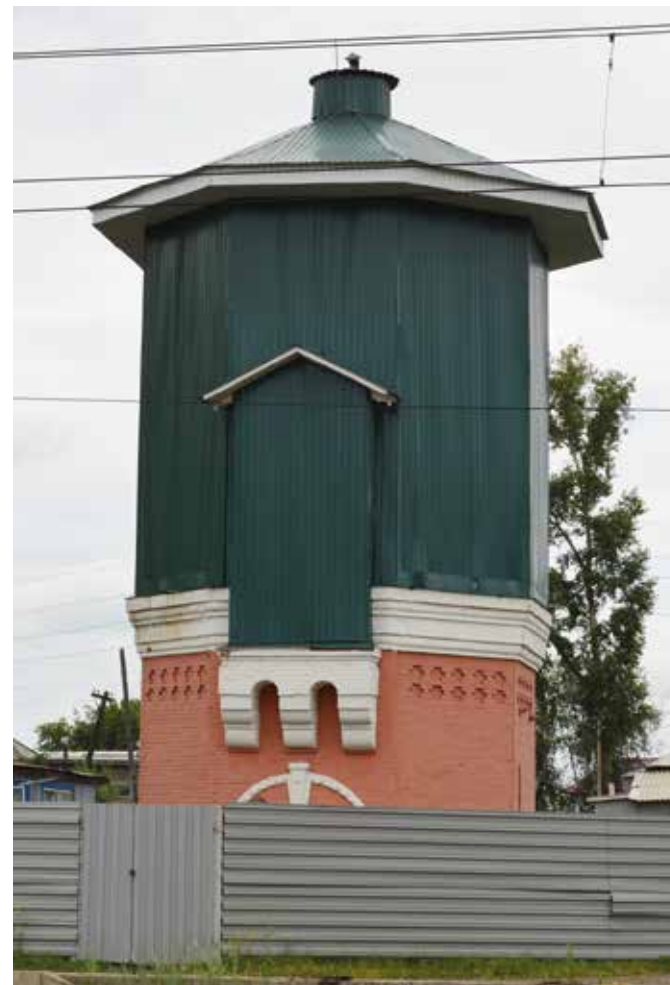
Водонапорная башня посёлка Козулька после ремонта
