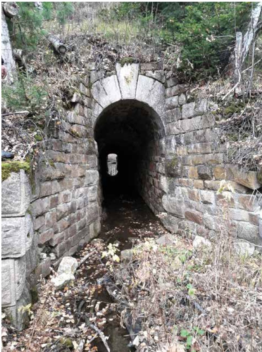
Водопрпускная труба между Шушково и Предгорье
