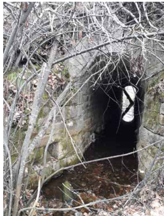
Водопропускная труба между Шушиково и Предгорье
