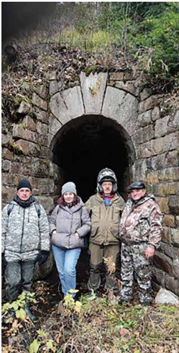
Водопротусная труба под старой железной дорогой
